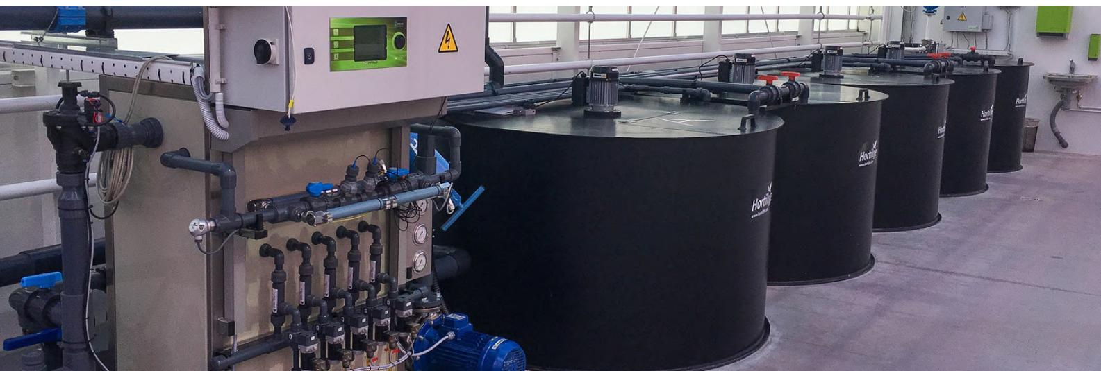
Наши климатические компьютеры идеально подходят для управления системами орошения сторонних производителей. Также возможно интегрировать определенные компьютеры Sercom в системы дозирования от других поставщиков. При наличии запроса мы также можем поставить свою собственную систему полива.
